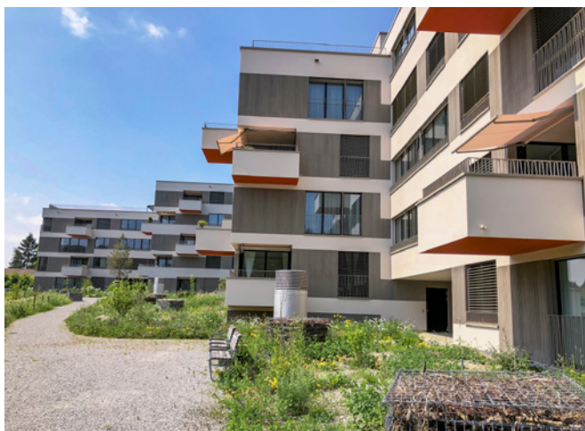
Aussenraum mit öffentlich zugänglichem Weg
