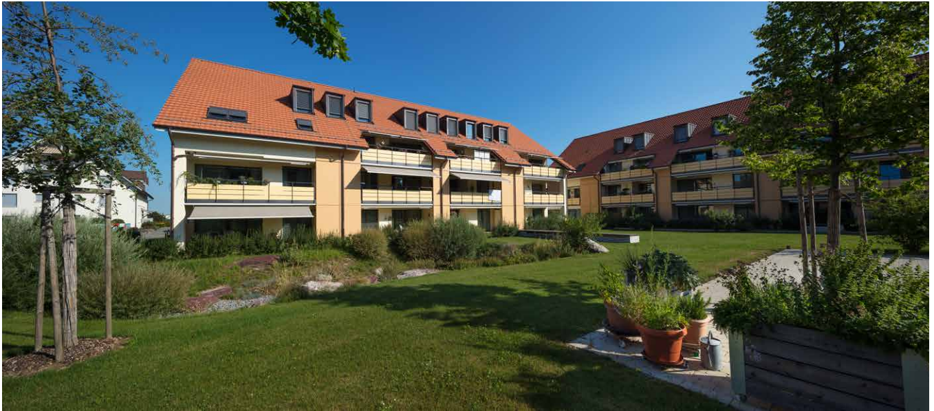
Garten und die zwei Gebäude des Sunnehofs
